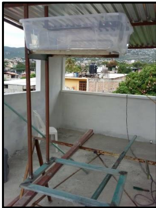
Ilustración 3 -Construcción de la estructura en metal
